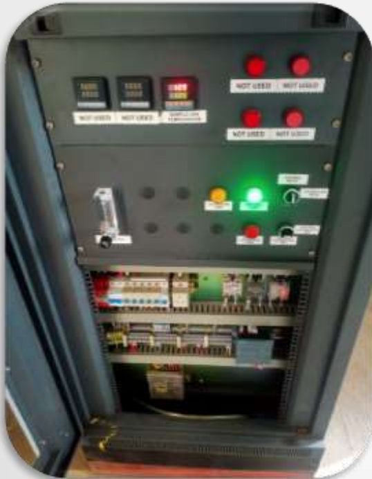
Perbaikan & Penormalan CEMS PLN PLTU Pulang Pisau
