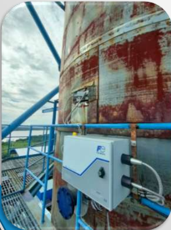
Perbaikan & Penormalan CEMS PLN PLTU Pulang Pisau
