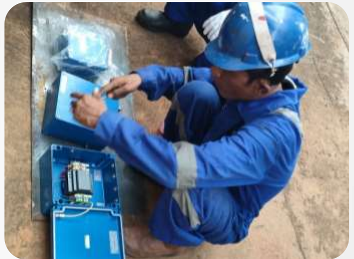
Perbaikan & Penormalan CEMS (PLN PLTU Pulang Pisau)
