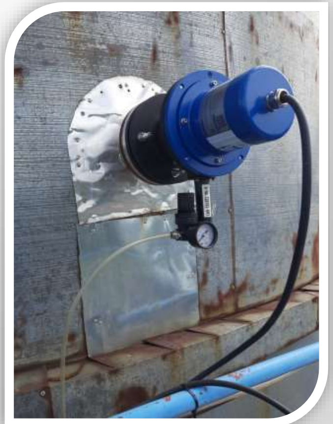
Perbaikan & Penormalan CEMS PLN PLTU Pulang Pisau
